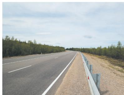
В Забайкальском крае Могочинский филиал АО «Труд» с опережением календарного графика завершил работы по ремонту участка км 502 – км 511 автомобильной дороги Р-297 «Амур». По объекту ремонта км 511 – км 520 ведутся работы по устройству охлаждающих берм из камня для предотвращения оттайки вечной мерзлоты в основании дороги. В рамках содержания автодороги и искусственных сооружений на участке км 380 – км 741 ведутся работы по подготовке к зимнему содержанию.
