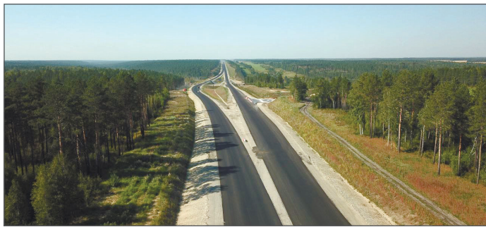
Строительство обхода Усолья-Сибирского, Иркутская область
