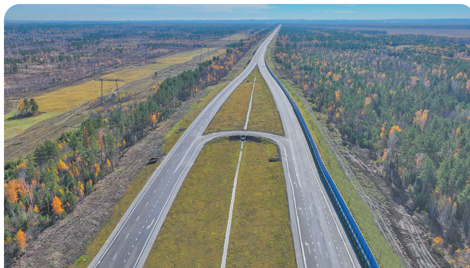
Новый участок федеральной трассы длиной почти 43 километра.
