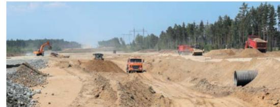
— Здесь очень много коммуникаций: теплосети, нефтепровод, этиленопровод, большое количество кабелей связи. Значительный объем земляных работ: только на насыпь ушло более двух миллионов кубометров земли. А доставка на место гигантских бетонных балок, из которых собирают мосты, — это вообще целая спецоперация.
