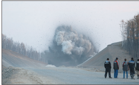
Буровзрывные работы, Соловьевский
