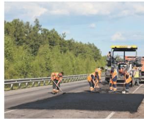
Силами Амурского филиала АО «Труд» выполняются работы по ремонту участка км 968 – км 980 автомобильной дороги Р-297 «Амур». Ведутся работы по фрезерованию покрытия и устройству основания дорожной одежды методом холодной регенерации. Также на участке содержания км 741 – км 1215 ведутся работы по ямочному ремонту, устранению просадок, замене элементов обустройства.
