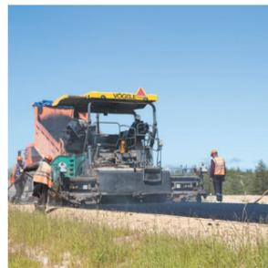
На острове Сахалин силами Охинского филиала АО «Труд» ведутся работы по объекту капитального ремонта автомобильной дороги А-393 Южно-Сахалинск – Оха на участке км 719 – км 730. Выполняются работы по отсыпке земляного полотна, замене водопропускных труб, устройству основания из ШЦПС смешанной с комплексными вяжущими материалами и устройству покрытия из асфальтобетона. В 2024 году намечен ввод объекта в эксплуатацию.
